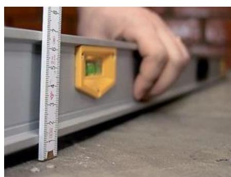
Необходимая толщина слоя заливки - это максимальный показатель отклонения от нижнего края рейки до крайней точки углубления, который определяется по результатам всех выполненных замеров с помощью правила.
